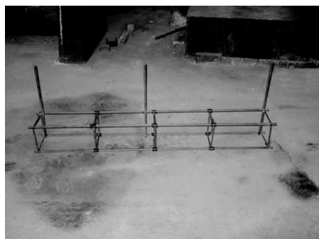
Figura 1. Disposizione dell'armatura nei travetti nel calcestruzzo armato.
