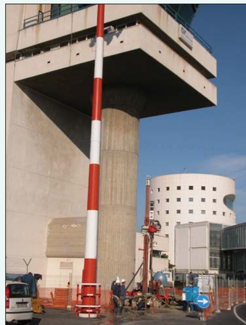
Figura 6 - Le indagini in situ delle prove geotecniche
