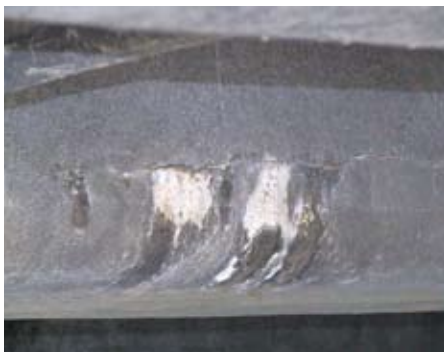
Figura 8 - Lesione con essudazione di prodotti carbonatici
