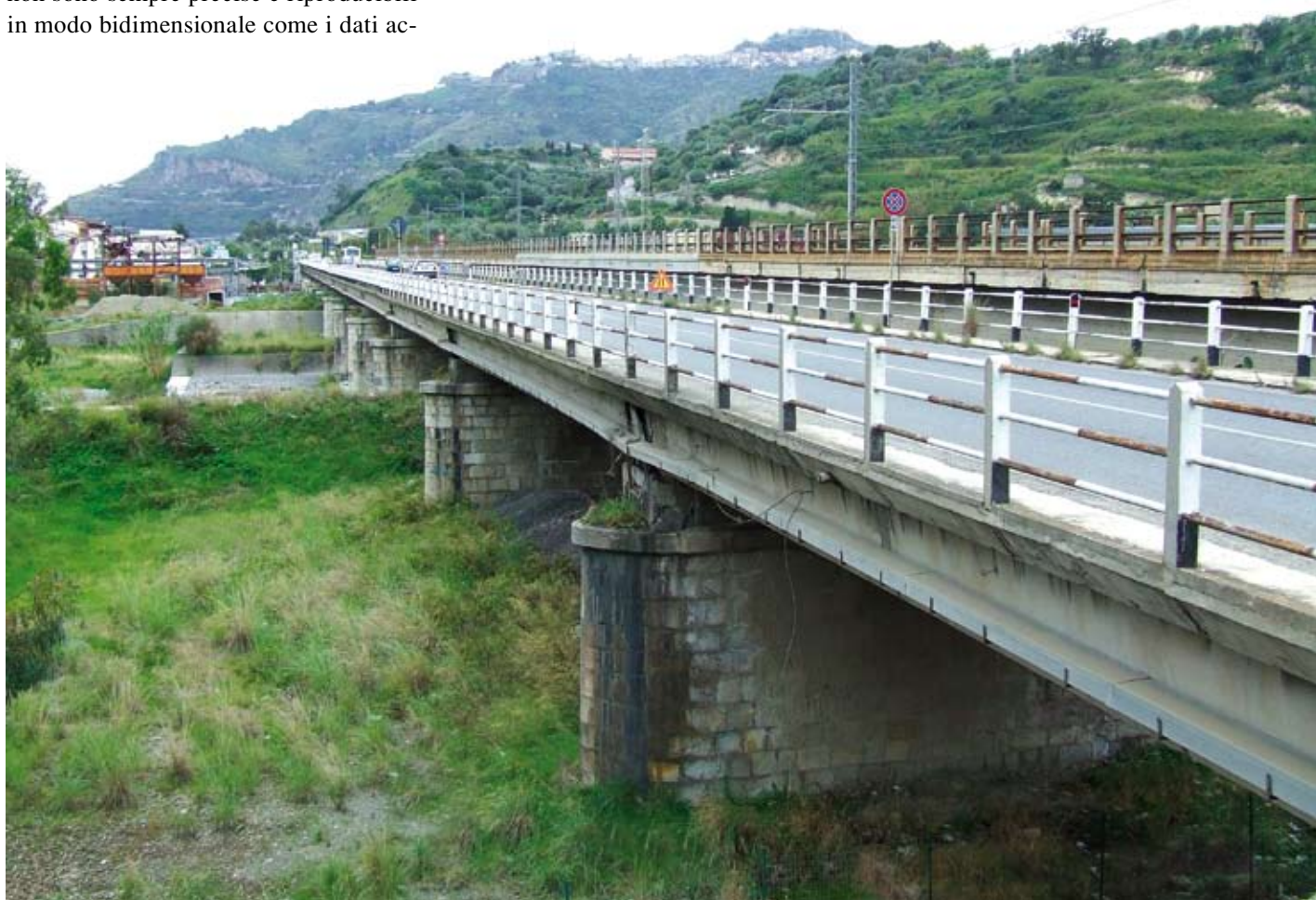
Figura 3 - Vista d'insieme del viadotto
