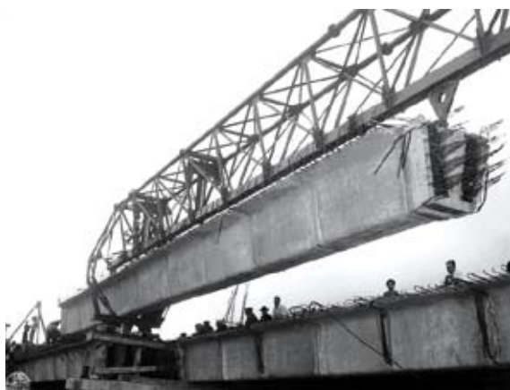
Figura 5 - Fase di posizionamento di una trave (foto d'epoca)
