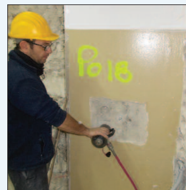
8. La prova di estrazione prevede l'estrazione di un tassello di geometria nota mediante un martinetto idraulico cavo di trazione contrastato da un anello posto sulla superficie di prova
