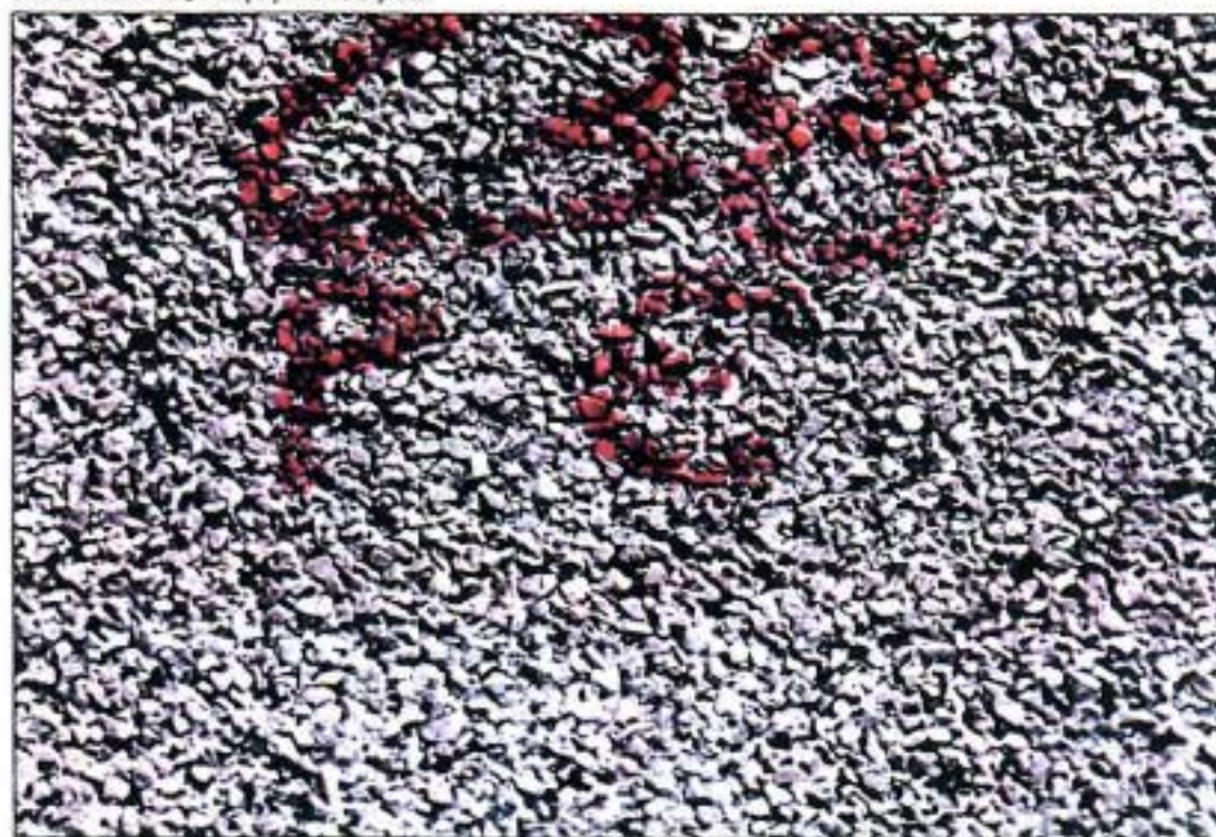
Foto 3. Pavimentazione tipo prima della prova
