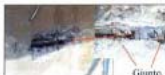
Cavi scoperti in corrispondenza del giunto tra i conci: si noti l'assenza della guaina di protezione
