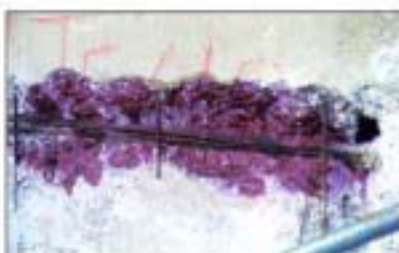
Cavi scoperti in corrispondenza del giunto tra i conci: si noti l'assenza della guaina di protezione
